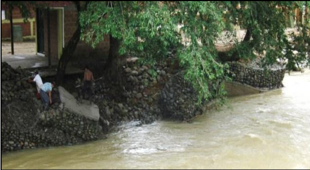
Afectación del muro de contención por efecto de la corriente (Río Rumiayaco). 2009.
